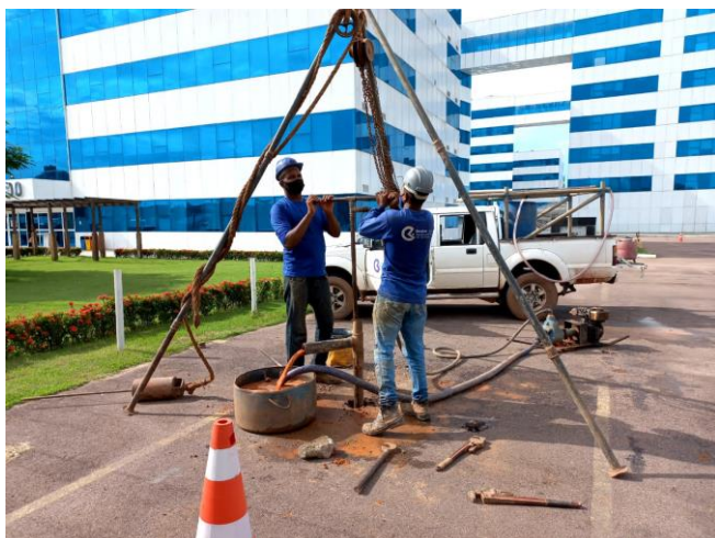
Foto 3 - Sondagem pelo processo de lavagem
